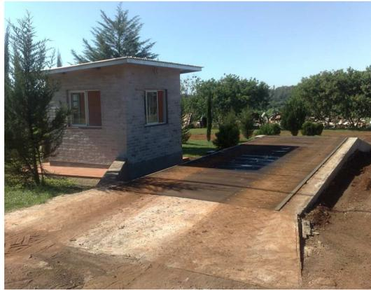
**Figura 1. Balanza para control de peso de ingreso de residuos**
